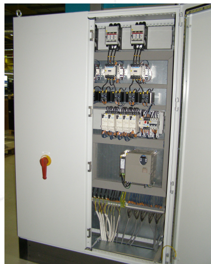
4. ábra: Villamos fűtésű kemence erősáramú szekrény
